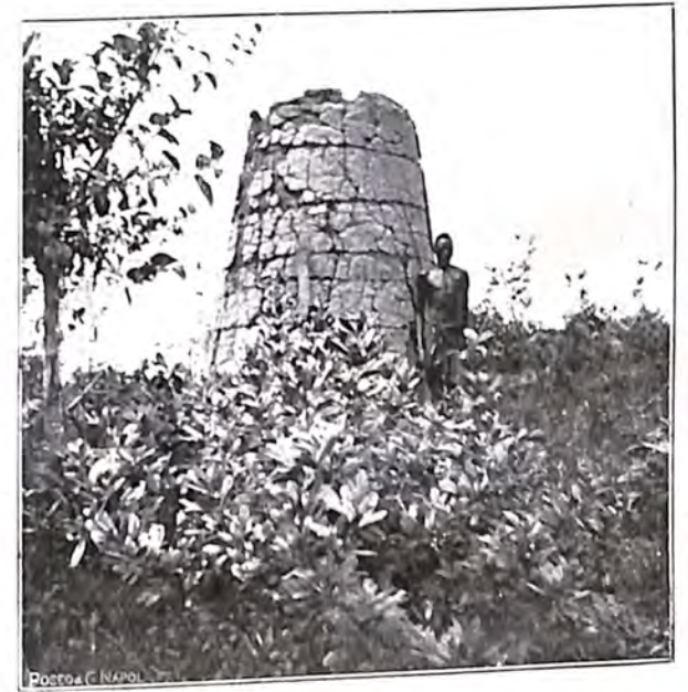
Forno Bemba per estrarre ferro.
